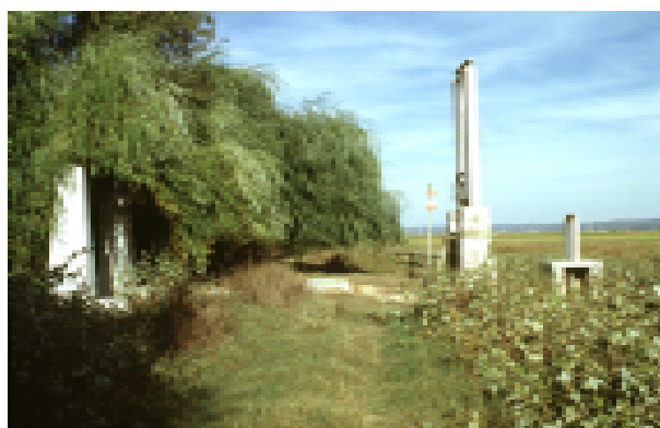
Comportas (à direita), antigo sistema de bombagem (à esquerda).
